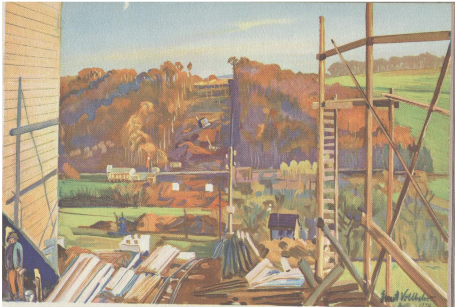
Baustelle der Sulzbachbrücke
