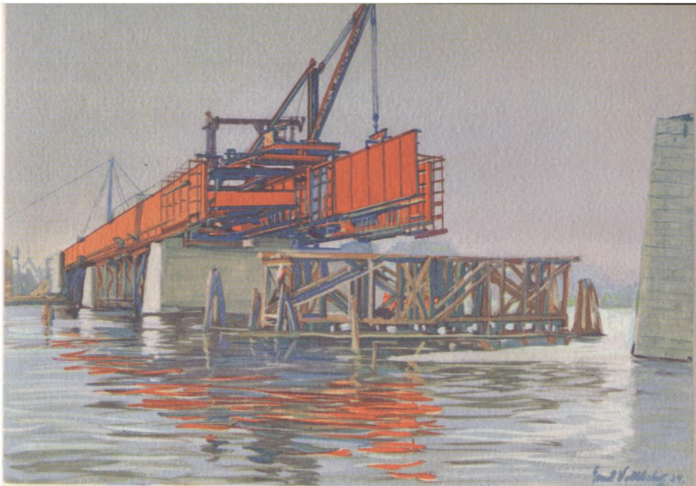
Aufstellung des Überbaues für die Mainbrücke bei Griesheim
