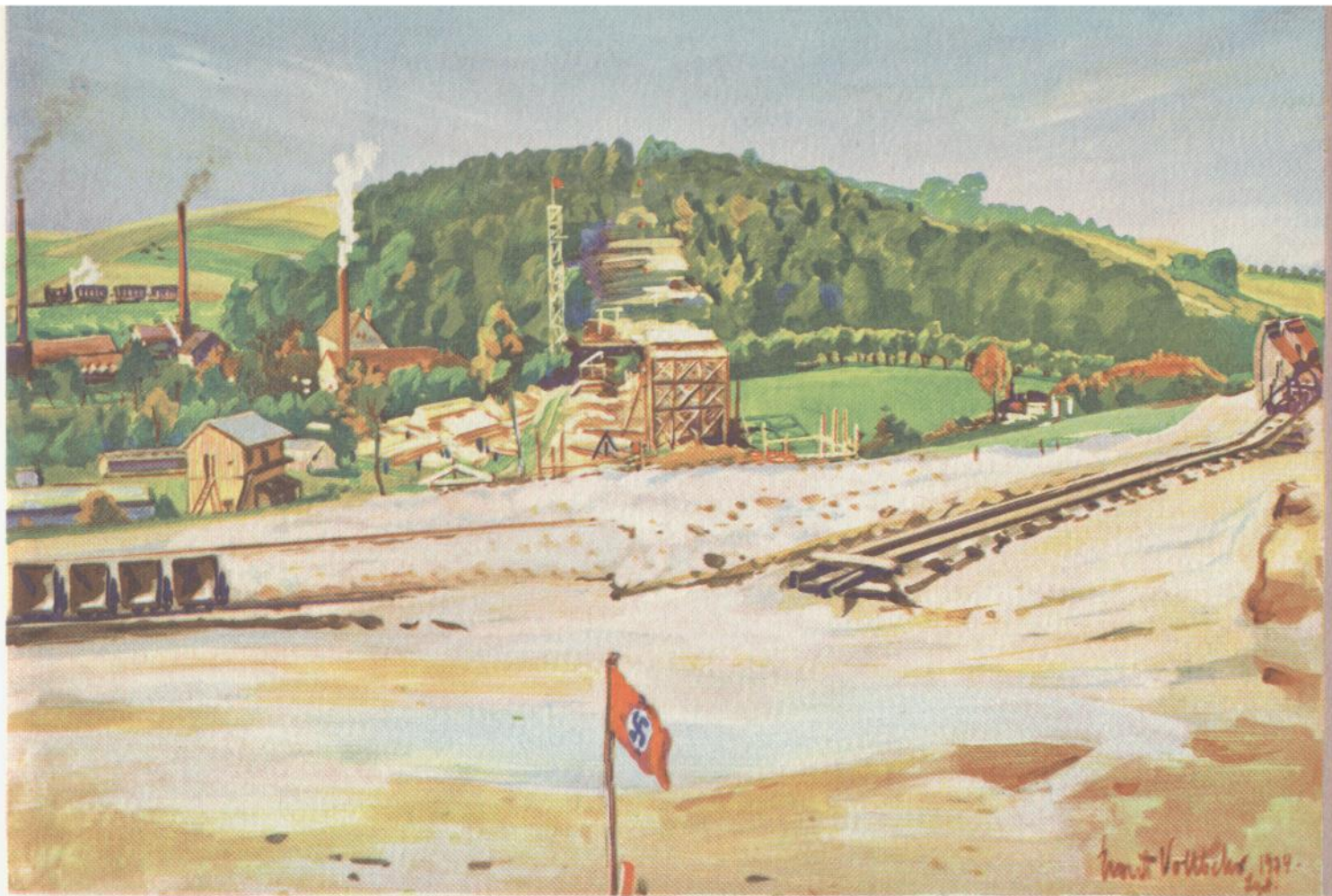
Baustelle der Saubachbrücke
