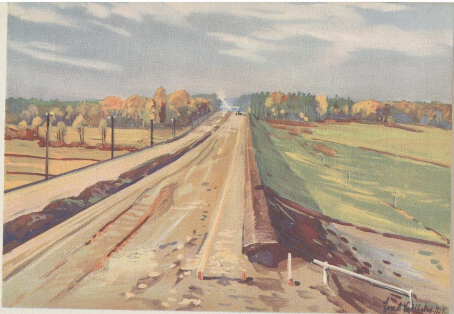
Die Autobahn auf der Schachthorst bei Dibbesdorf
